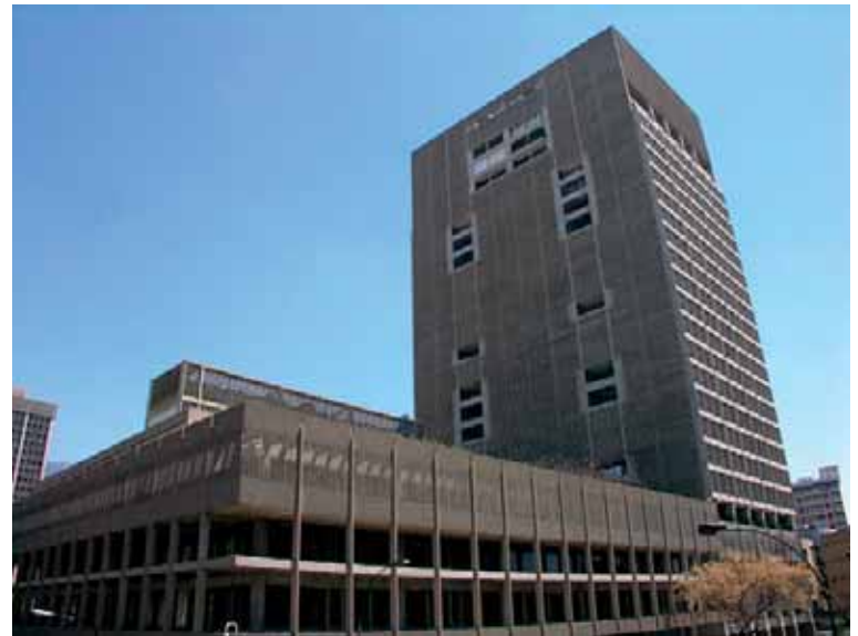
Edificio principal del Banco Central de Venezuela.
