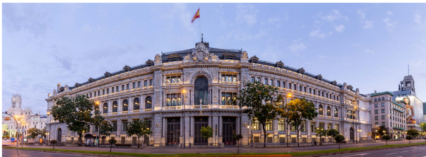
Vista panorámica del edificio de la sede central del Banco de España.
