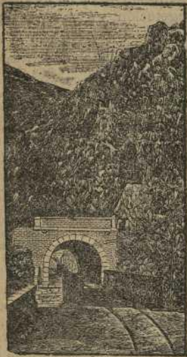
TÚNEL DE EMBID.
